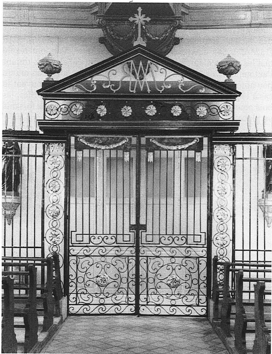
Grilles du narthex de la Basilique Notre-Dame, partie centrale avec la porte à double battant. Vue de l'est. Œuvre du maître-feronnier Georges-Henri Haller, 1787-1788.
